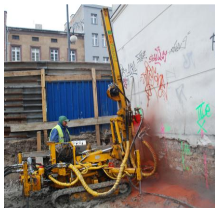
PRZEWIERTY RDZENIOWE PRZEZ ISTNIEJĄCE FUNDAMNTY
