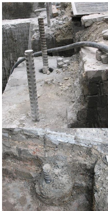
ODKOPANE GŁOWICE MIKROPALI
