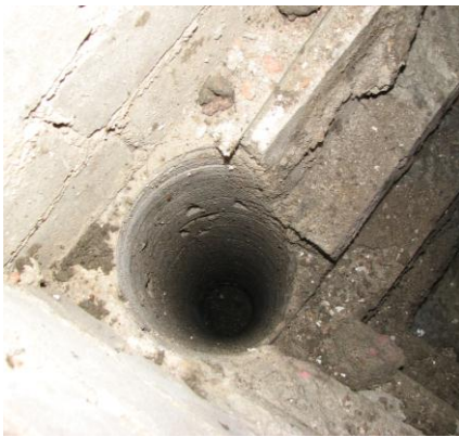
PRZEWIERT RDZENIOWY PRZEZ ODSADZKĘ FUNDAMENTOWĄ
