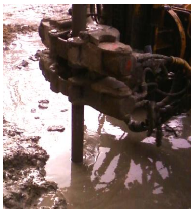
FORMOWANIE KOLUMNY PRZY WYSOKIM POZIOMIE WÓD GRUNTOWYCH
