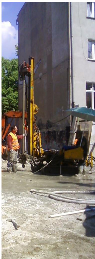
KONTROLA POZIOMU POSADOWIENIA PODCZAS FORMOWANIA KOLUMN
