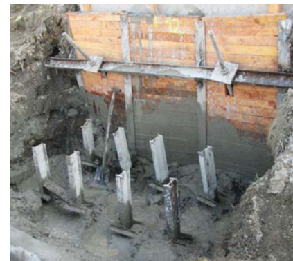
ZABEZPIECZENIE SKARPY ŚCIANKĄ BERLIŃSKĄ
