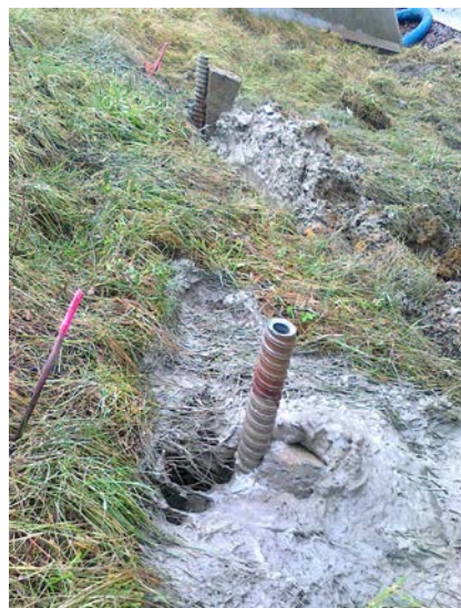
WYKONANE KOTWY GRUNTOWE
