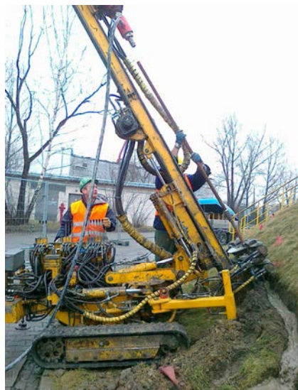
WIERCENIE KOTWY GRUNTOWEJ
