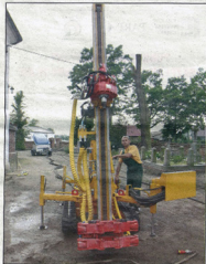
Dwie takie maszyny wykonają 120 centymetrowych kolony
